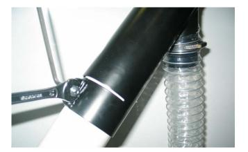
Aflojar la T metálica donde esta conectado el tubo flexible, de modo que pueda girar libremente
