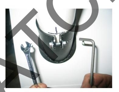
Apretar el tubo en la brida del silo, con la ayuda del tornillo M6 x 25mm y las dos arandelas 18mm x M6
